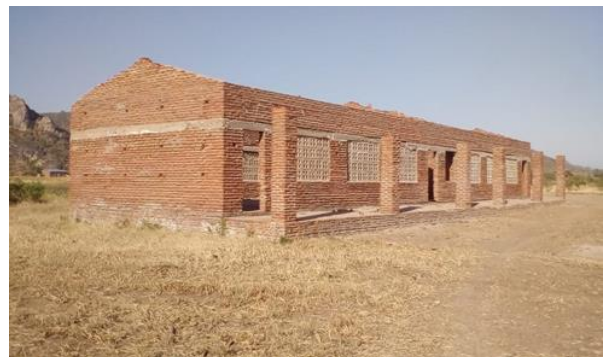
Foto 2: school in aanbouw mei 2020
